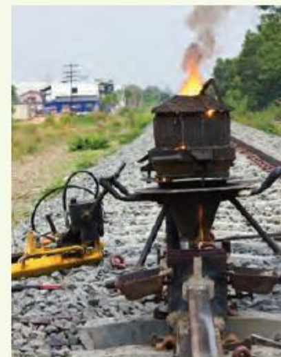
2. A vasúti sínek hegesztése termitreakcióval szintén redoxireakció
